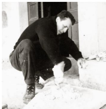
Fig.79: Bandeira Mello preparando a argamassa de cal, Poggio Bustone, 1962.
